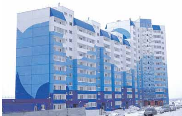
Жилой дом КПД-1 в Ульяновске.
